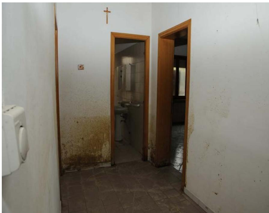
**Figura 65:** Fiume Ete Morto - Casette d'Ete - Edifici alluvionati - Sono evidenti le tracce del livello raggiunto dalle acque ai piani terra delle abitazioni
