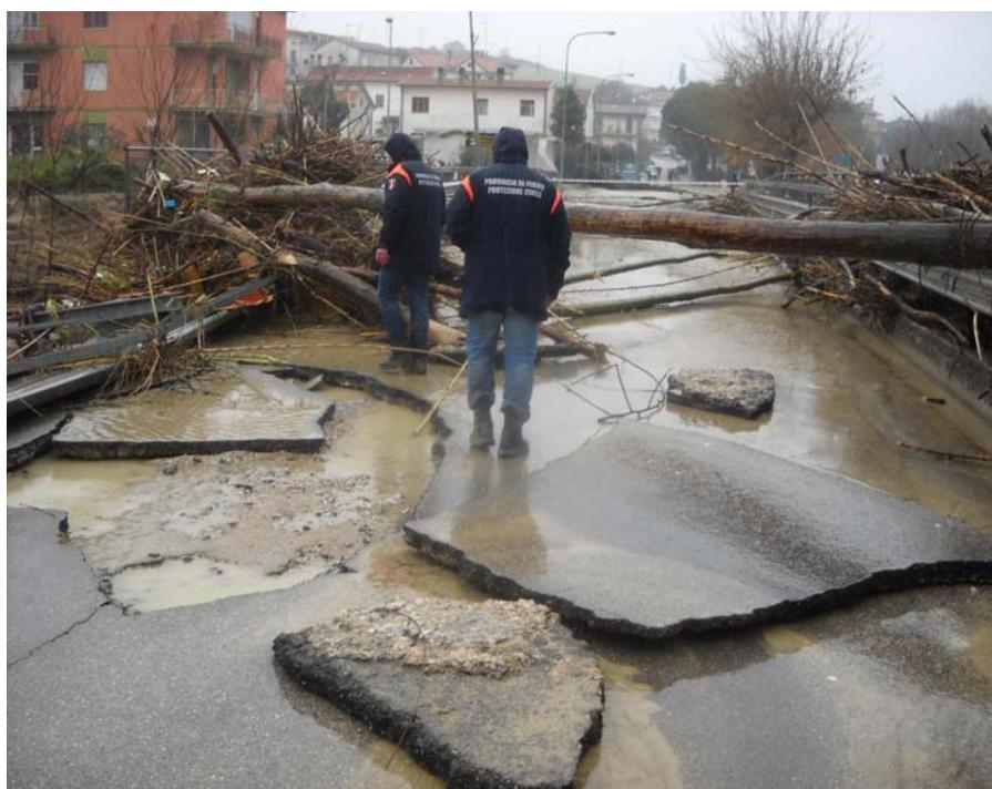
**Figura 61:** Fiume Ete Morto - Casette d'Ete - Ponte gravemente danneggiato dalla piena
