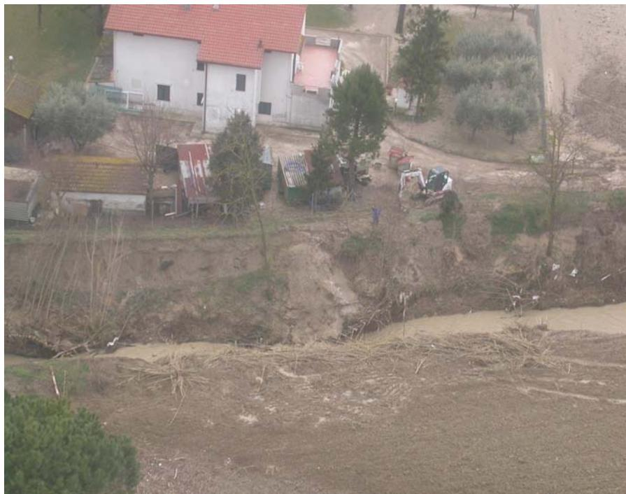
**Figura 82:** Torrente Scaricalasino - Cedimento dell'argine in prossimità di un'abitazione
