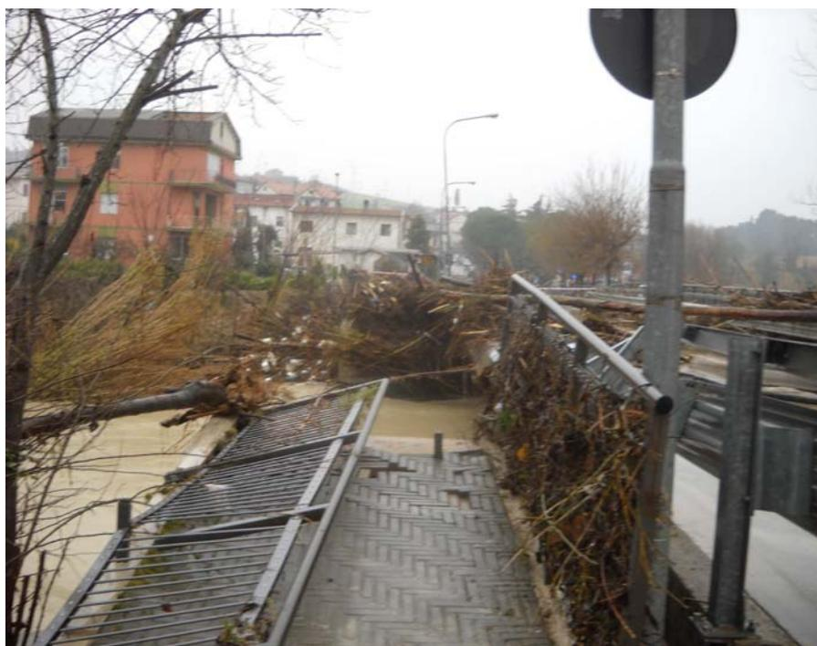
**Figura 60:** Fiume Ete Morto - Casette d'Ete - Ponte gravemente danneggiato dalla piena
