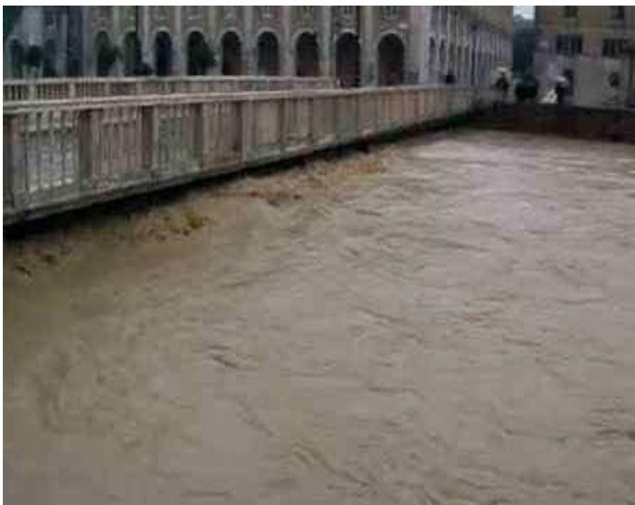
**Figura 91:** Fiume Misa - Comune di Senigallia - Ponte stradale di Via Cavallotti - La piena è arrivata ad occludere totalmente la luce del ponte, non ha scavalcato il piano stradale solo per poche decine di centimetri
