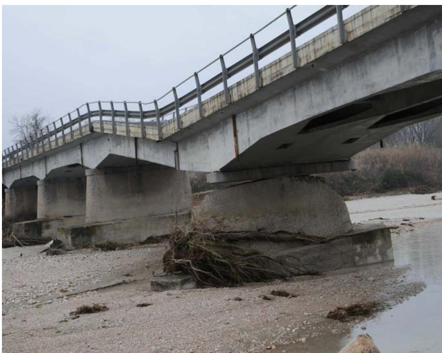
**Figura 57:** Fiume Fiastra - Strada Prov.le Corridonia - Colbuccaro - Ponte danneggiato (pila scalzata)
