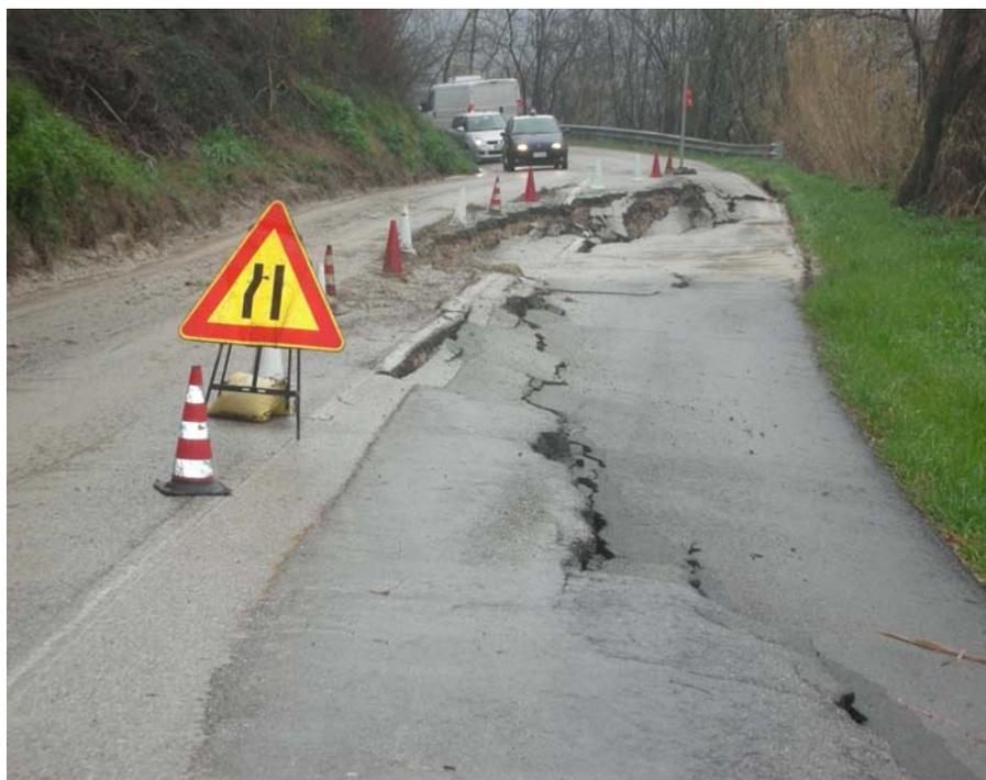
**Figura 93:** Comune di Montottone (FM) - smottamento al km 185 della Strada Provinciale Montottone
