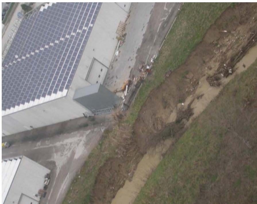
**Figura 83:** Torrente Scaricalasino - Erosione della sponda sinistra in prossimità di un insediamento industriale
