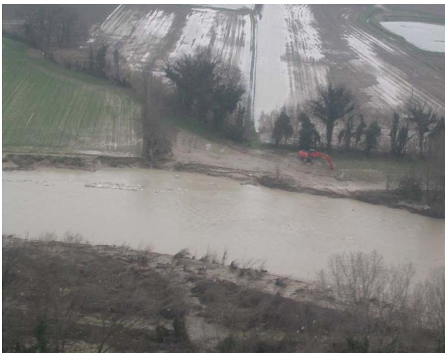
**Figura 77:** Fiume Potenza - Erosione della sponda sinistra e campi allagati dall'esondazione in località Chiarino
