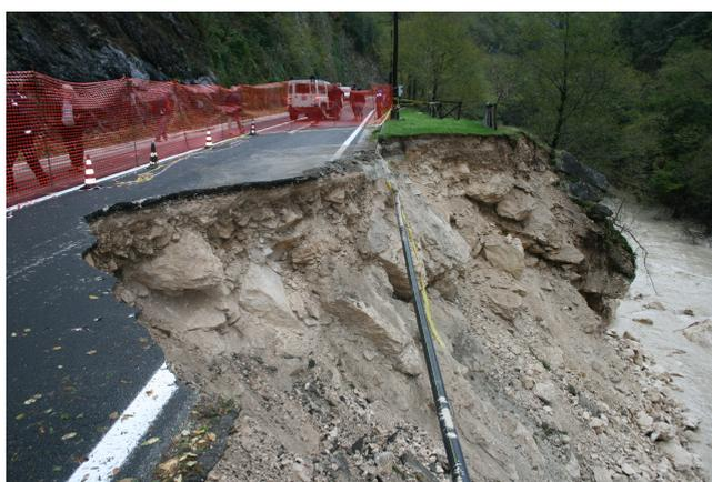
**Figura 32:** Frana lungo la strada in prossimità di Frasassi
