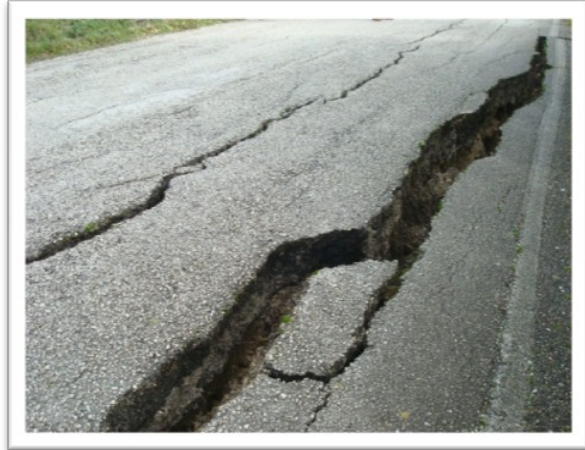
Sigillo. Danneggiamento della SP 244
