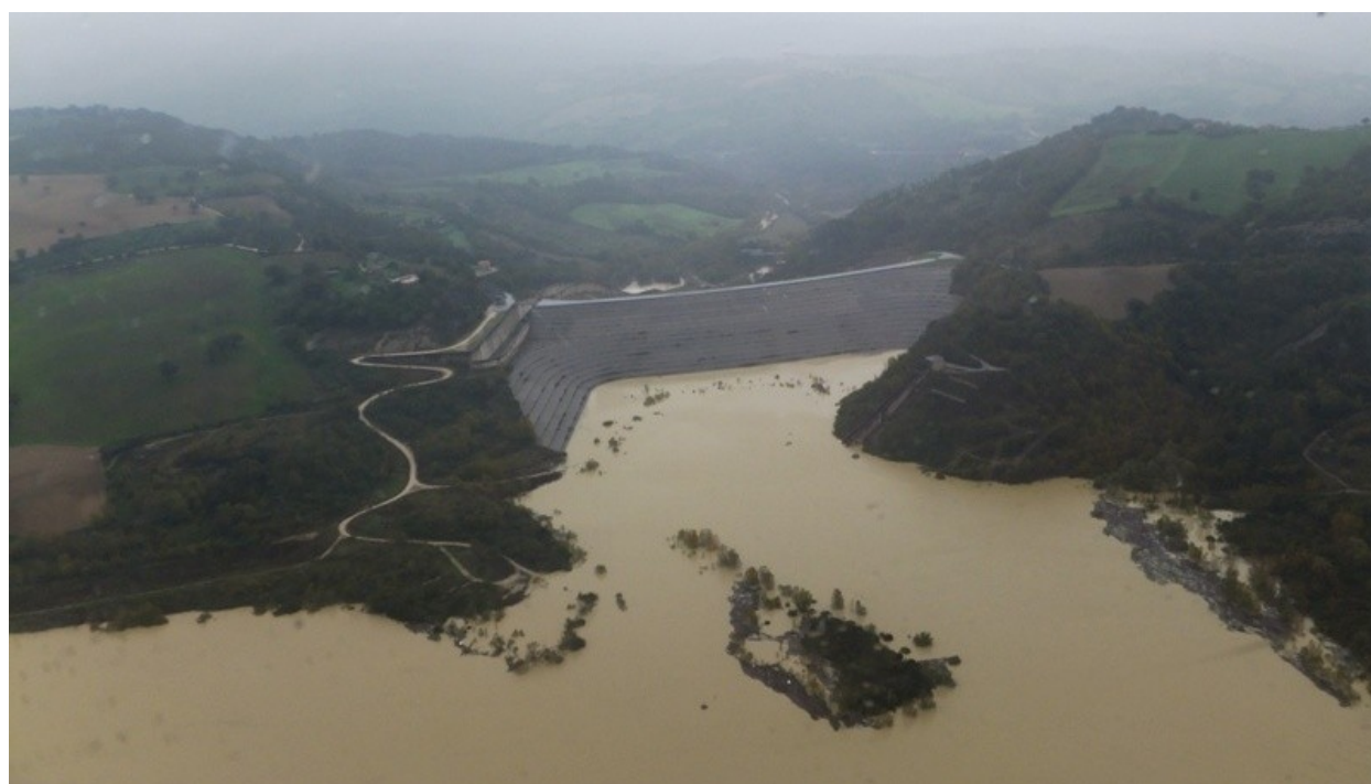
FOTO 2 E 3: DIGA DI CASANUOVA SUL F. CHIASCIO
